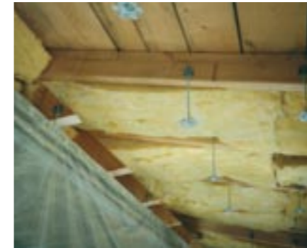
Construcția acoperișului a fost izolată la interior cu vată de sticlă ISOVER de 200 mm între căpriori și sistemul de montare Rosatwist.
