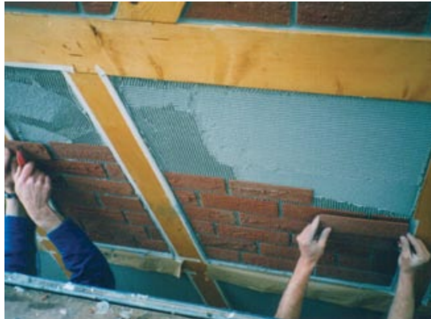
Fronton cu fermă reconstruit. Fâșiile de piatră au fost lipite pe umplutura de vată minerală.
