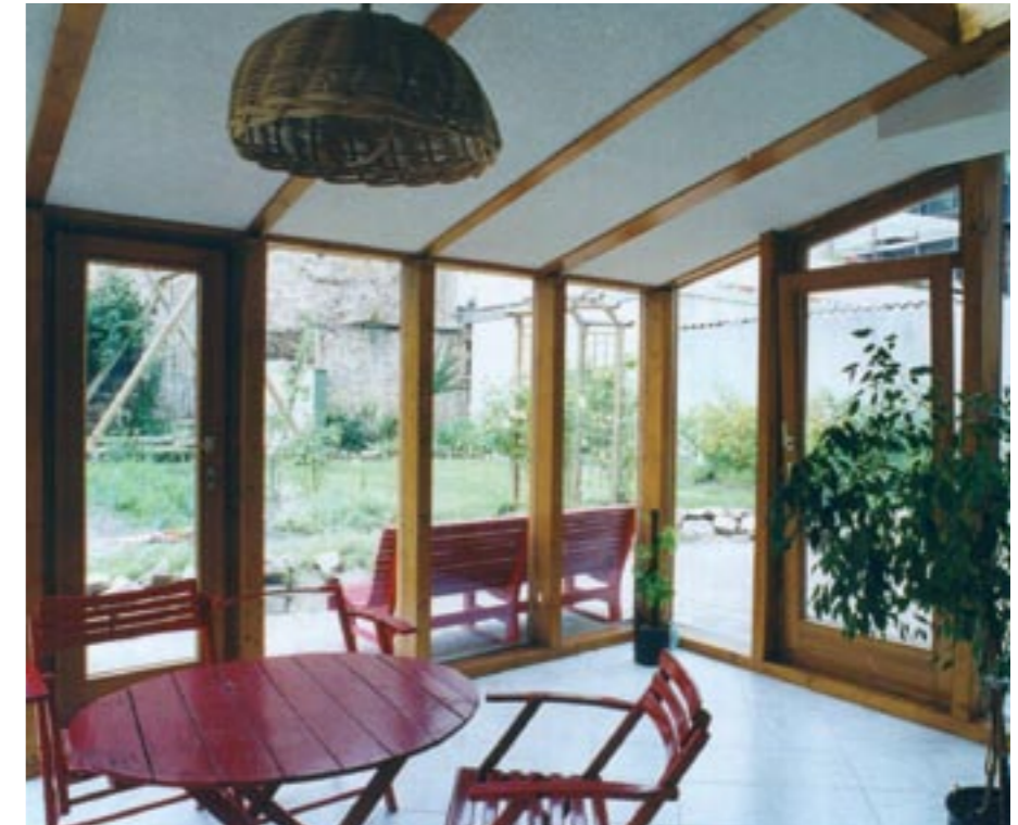
Construcția acoperișului a fost izolată la interior cu vată de sticlă ISOVER de 200 mm între căpriori și sistemul de montare Rosatwist.
